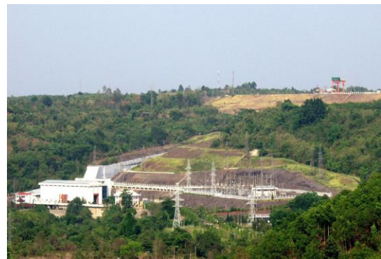
Nhà máy thủy điện Thác Mơ
