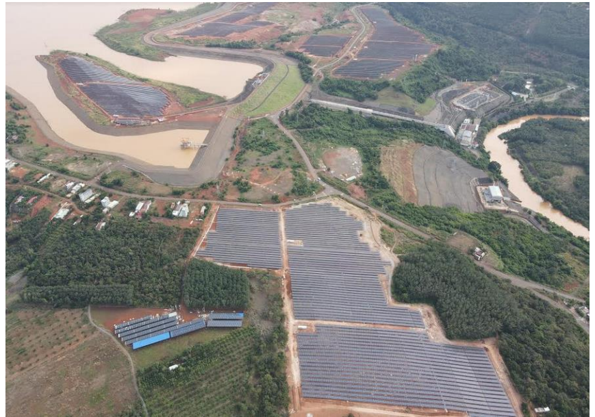
Toàn cảnh NMTĐMT Thác Mơ 50MWp
