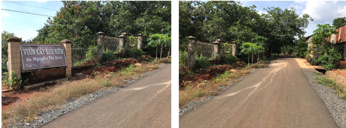
Hình 6-Hiện trạng giao thông tiếp cận khu vực lập quy hoạch
