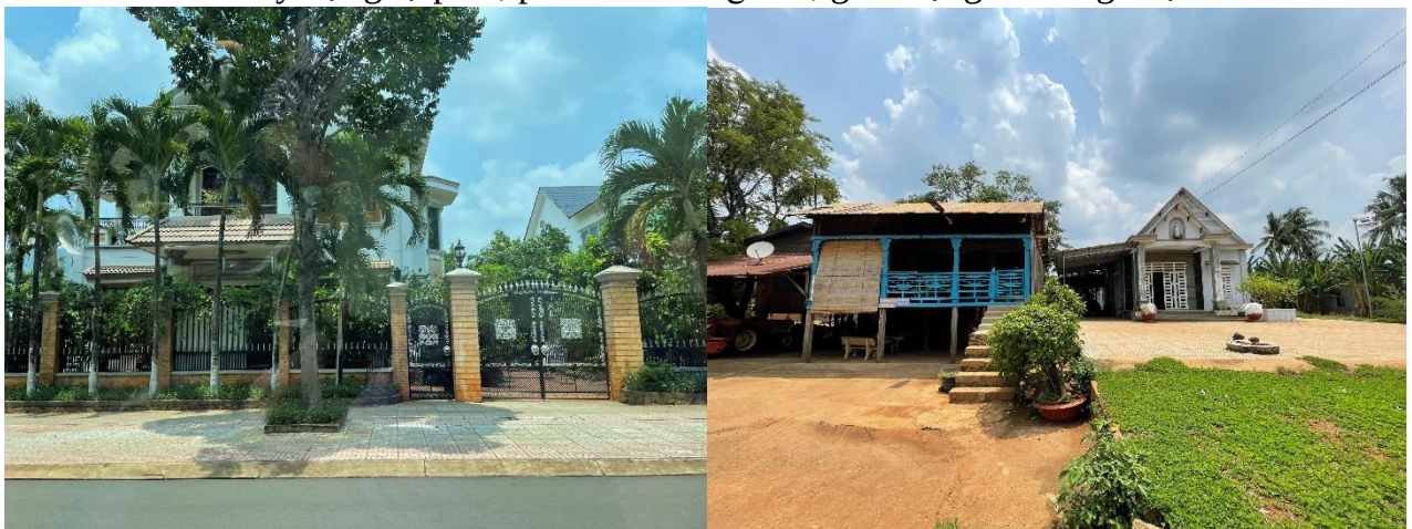
Hình 6. Nhà ở hiện trạng dọc đường.
